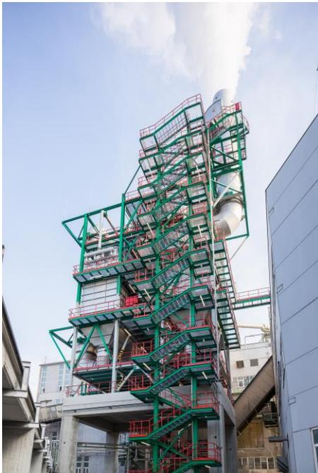
Foto: Der Neue Nass-Elektrofilter am
