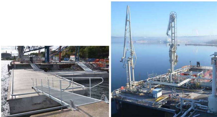
Figur Nya flytpontoner till vänster som installerades 2019 och nya lastarmar som färdigställdes under 2018 i hamnen Havden.
