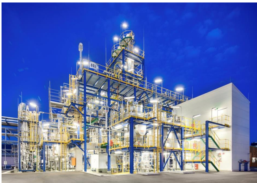
Die neue Borealis Sirius Katalysatoranlage in Linz
