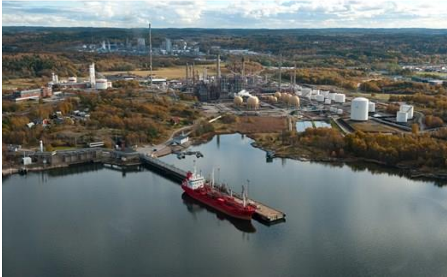
Borealis Cracker in Stenungsund, Schweden. © Borealis
